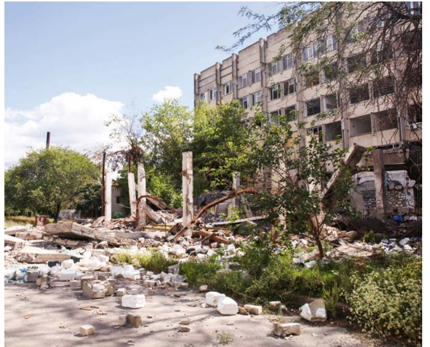
Zerstörtes Institutsgebäude. Foto: Studio KIVI/stock.adobe.com
